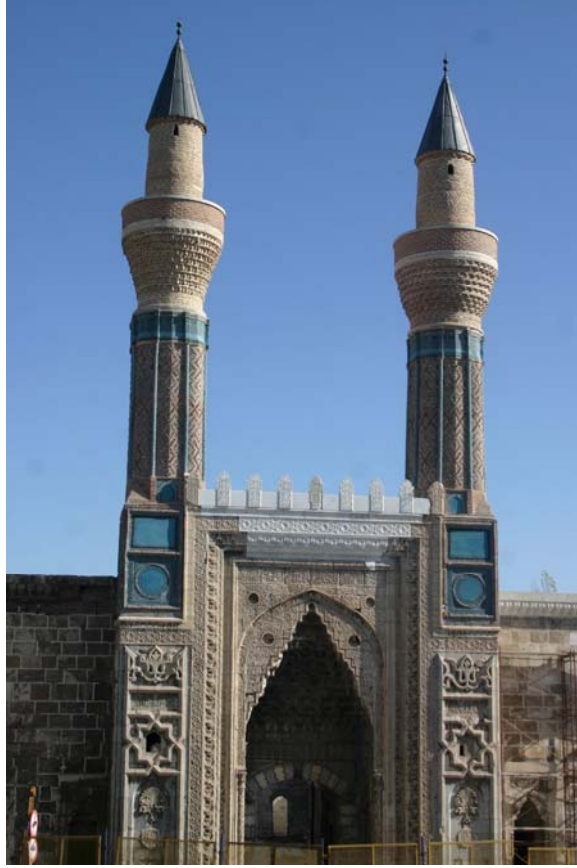
Gökmedrese (Restorasyondan sonra)
